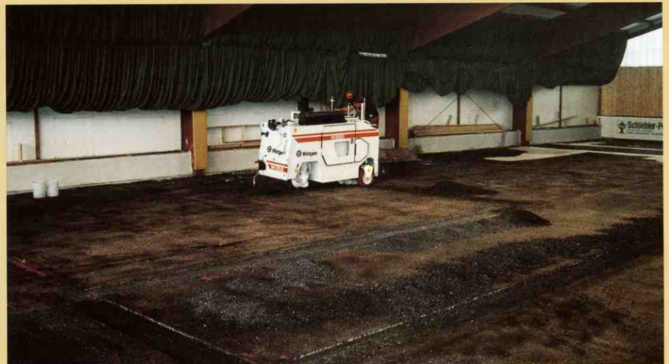
新しい材料で補填される場所のエッジは楔形に切削されます。
