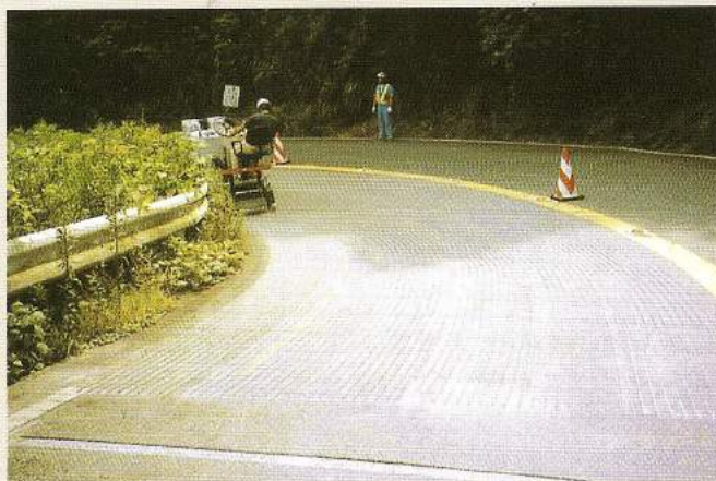
発注元：滋賀県大津市 施工地：滋賀県大津市 施工期：平成11年7月 用途：カーブのスリップ防止 施工タイプ：縦溝9mmパターン/横溝108mm
