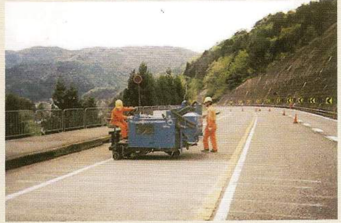
発注元：兵庫県 施工地：兵庫県養父郡閑宮町(R9) 施工期：平成16年4月 用途：制動効果 施工タイプ：横溝9mmパターン
