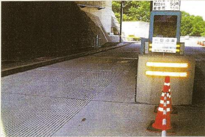
発注元：広島県 施工地：広島県尾道市向東町(料金所) 施工期：平成13年4月 用途：下り坂カーブの橋梁スリップ防止、料金所路面凍結防止 施工タイプ：縦溝9mmパターン
