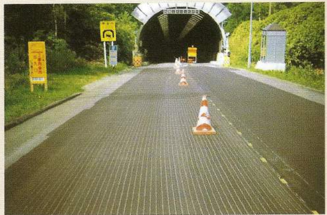
発注元：北海道開発局 施工地：北海道当丸峠 施工期：平成11年8月 用途：覆道出入口スベリ防止 施工タイプ：縦溝6×50mm(ピッチ)
