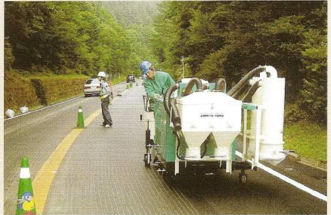
発注元：山梨県企画局 施工地：河口湖富士線有料道路 施工期：平成15年8月 用途：路面凍結抑制、スリップ防止対策 施工タイプ：縦溝9mmパターン/縦溝36mmパターン
