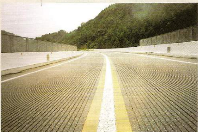
発注元：石川県道路公社 施工地：石川県中島町地内 施工期：平成00年0月 用途：高架部凍結防止、スリップ防止 施工タイプ：9mmパターン
