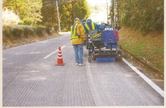
発注元：宮崎県延岡土木事務所 施工地：延岡市伊原町 施工期：平成16年3月 用途：下り坂交差点手前 施工タイプ：縦溝9mm/ターン(9×9×60)
