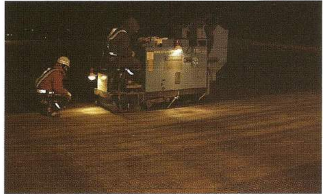
釧路空港滑走路 平成15年1月、平成16年1月
