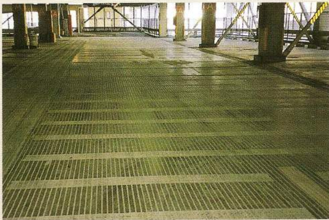
発注元：イトーヨーカ堂 弘前店 施工地：青森県弘前市(立体駐車場) 施工期：平成10年11月 用途：凍結スリップ防止 施工タイプ：縦溝6mmパターン
