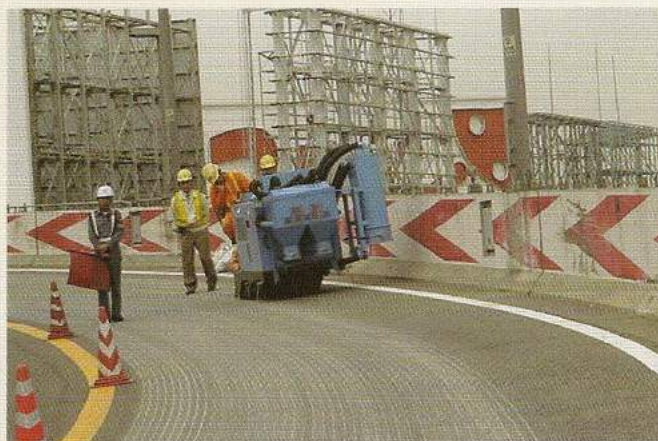
発注元：阪神高速道路公団 施工地：阪神高速11号線 施工期：平成13年7月 用途：カーブのスリップ防止 施工タイプ：縦溝9mm
