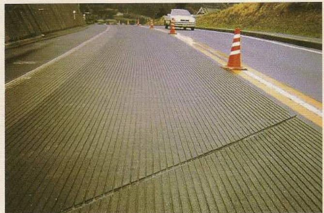
発注元：愛媛県 施工地：愛媛県八幡浜市 施工期：平成11年12月 用途：スベリ防止 施工タイプ：縦溝6mmパターン
