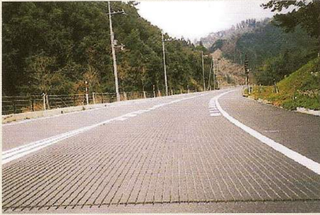
発注元：京都府宮津土木事務所 施工地：京都府宮津市(R178) 施工期：平成14年3月 用途：坂道スリップ防止 施工タイプ：縦溝9mmパターン
