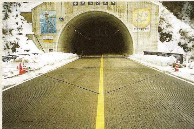
発注元：石川県輪島土木事務 施工地：石川県輪島道路穴水町(小二地区) 施工期：平成14年10月 用途：トンネル出入口スリップ防止 施工タイプ：縦溝39mmパターン
