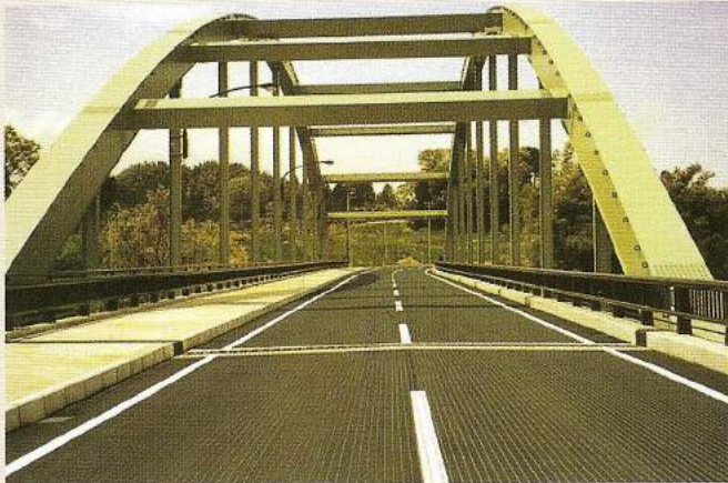
発注元：金沢市道路建設課 施工地：金沢市山川町中戸町内 施工期：平成12年4月 用途：下り坂カーブの橋梁スリップ防止、路面凍結防止 施工タイプ：縦溝9mmパターン
