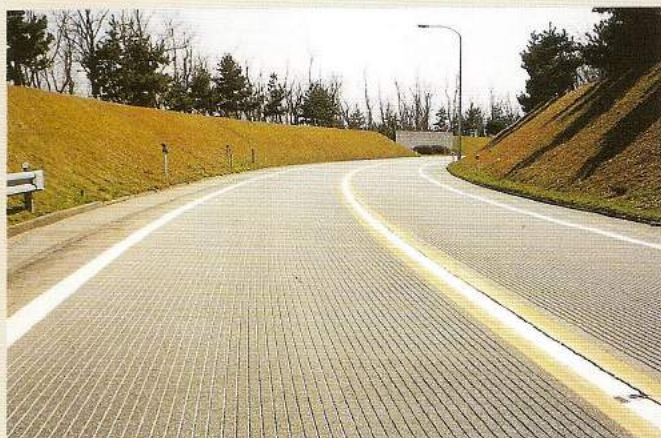
発注元：石川県道路公社 施工地：能登有料道路(宮坂地区) 施工期：平成14年7月 用途：カーブスリップ防止 施工タイプ：縦溝(9×6×60mm)
