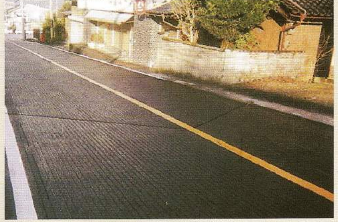
発注元：京都府宮津土木事務所 施工地：京都府与謝郡加悦町(R176) 施工期：平成16年1月 用途：下り坂スリップ防止 施工タイプ：縦溝9mmパターン
