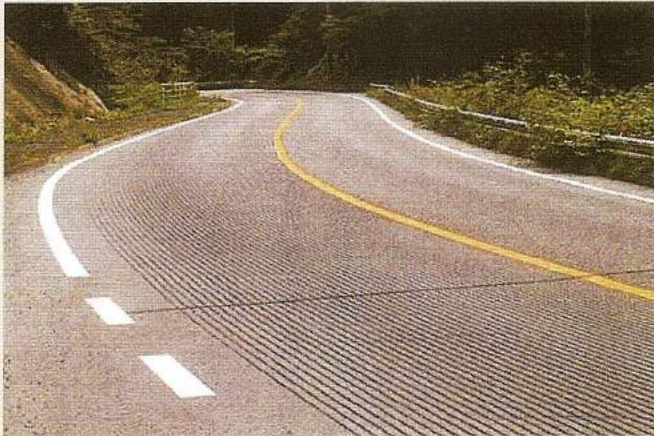
発注元：広島県備北地域事務所 施工地：広島県神石郡油木町 施工期：平成13年11月 用途：カーブのスリップ防止 施工タイプ：縦溝9mmパターン
