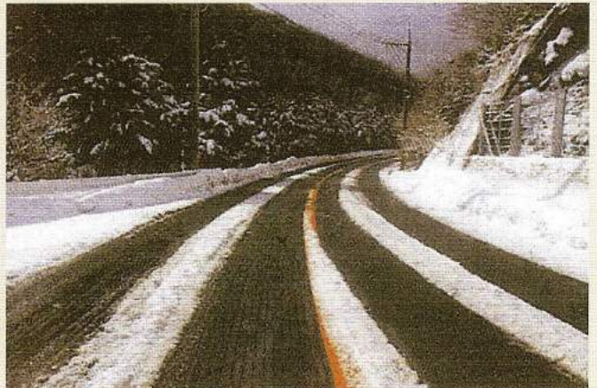
発注元：広島県備北地域事務所 施工地：広島県比婆郡西城町 施工期：平成15年11月 用途：スリップ防止、雪解け促進 施工タイプ：縦溝9mmパターン
