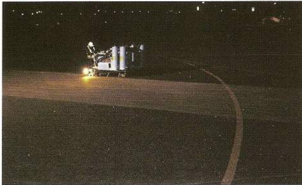
函館空港誘導路 平成12年11月
