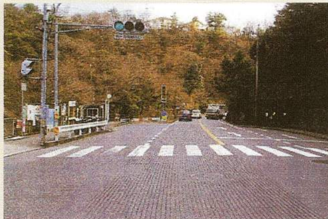
発注元：広島県呉地域事務所 施工地：広島県呉市二河峡町 施工期：平成15年12月 用途：下り坂カーブスリップ防止・凍結防止 施工タイプ：縦溝9mmパターン
