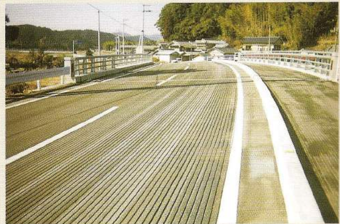
発注元：高知県 施工地：高知県内 施工期：平成16年4月 用途：橋梁上のスリップ防止、路面凍結防止 施工タイプ：縦溝9mmパターン
