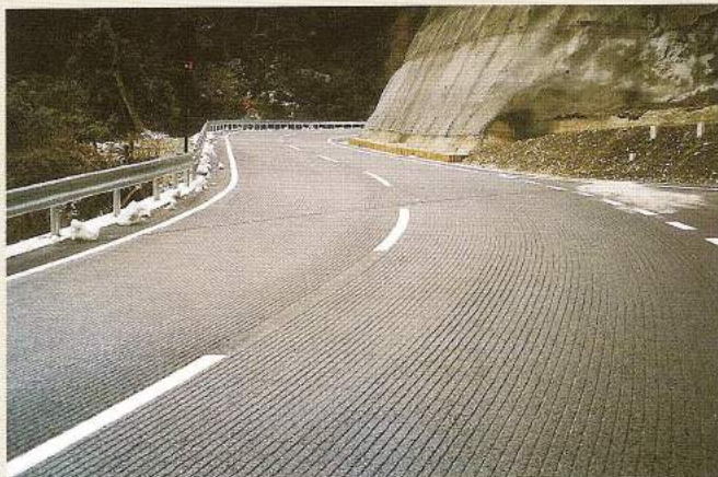
発注元：岐阜県春日村 施工地：岐阜県春日村(県道改良工事) 施工期：平成14年12月 用途：カーブのスリップ防止 施工タイプ：縦溝9mmパターン
