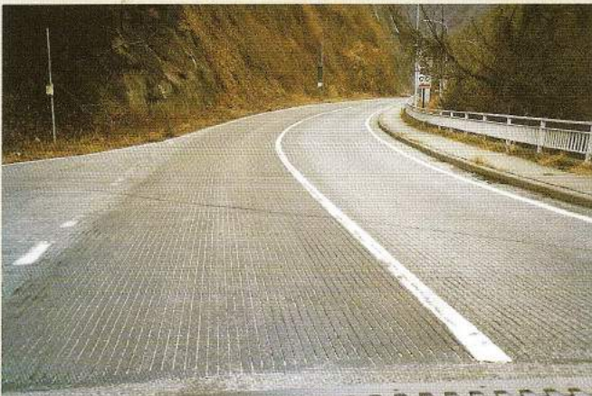
発注元：岐阜県 施工地：岐阜県揖斐斐川町 施工期：平成15年2月 用途：カーブのスリップ防止 施工タイプ：縦溝9mmパターン (9×4×100)
