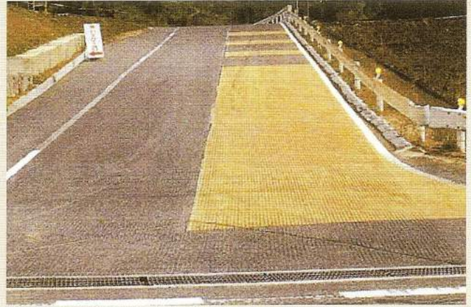
発注元：広島県東広島地域事務所 施工地：広島県賀茂郡福宮町 施工期：平成14年1月 用途：交差点下り制動距離短縮・スリップ防止 施工タイプ：縦溝6mmパターン
